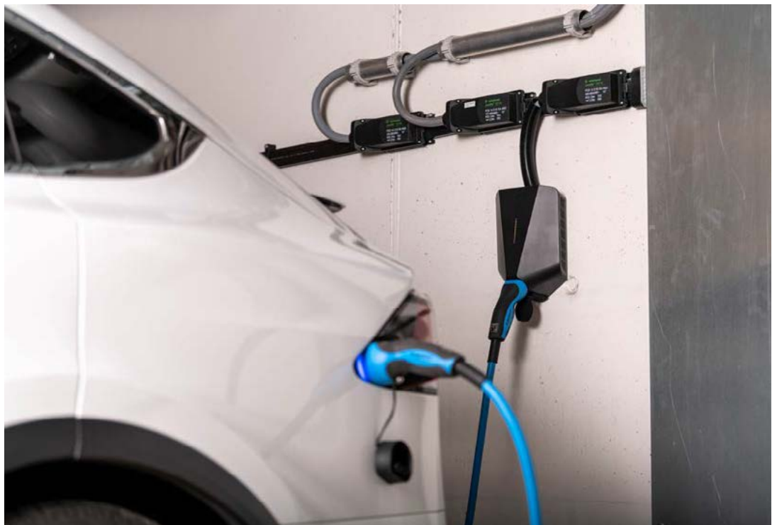
Wallbox für langsames und batterieschonendes Laden über Nacht.
