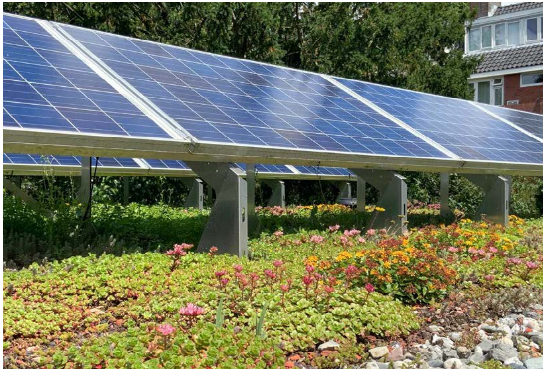
In Mehrfamilienhäusern sind eine PV-Anlage und die Elektromobilität beste Partnerinnen.
