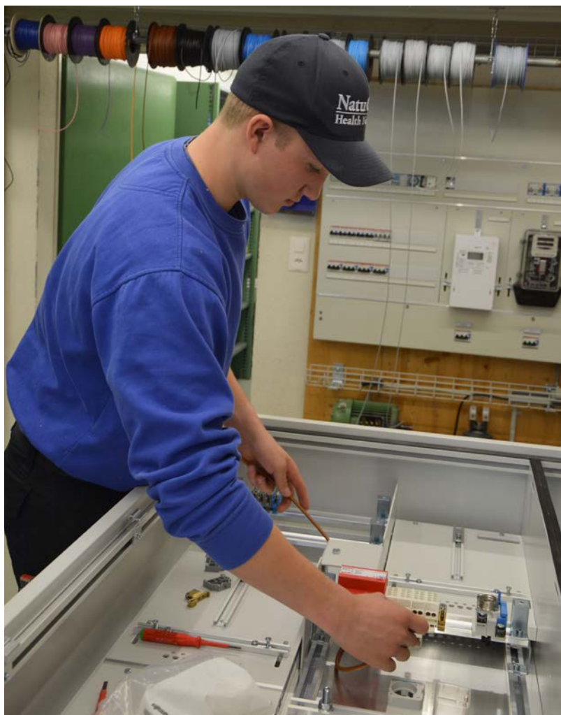
David Knobel bei der Arbeit als angehender Elektroinstallateur EFZ.
