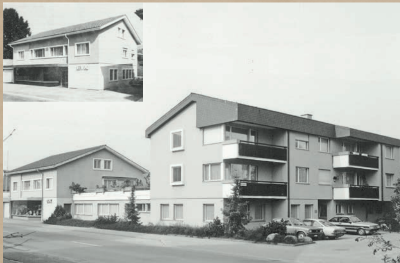
Wohn- und Geschäftshaus der EVK: Neubau 1960/61 (kleines Bild) und nach der Erweiterung 1973/74.
