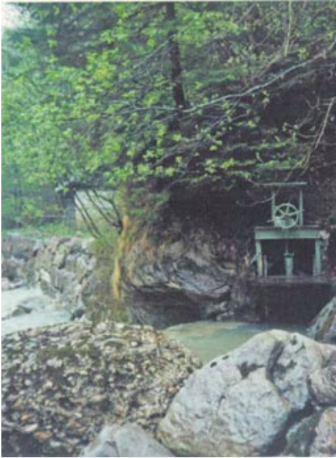
Wasserfassung und Stausee des Kleinkraftwerkes Wilen.
