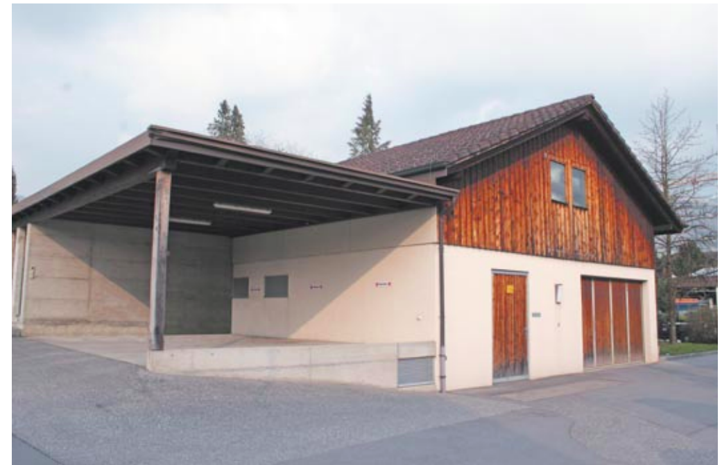
Haupt- und Messstation der EVK, erbaut 1983.
