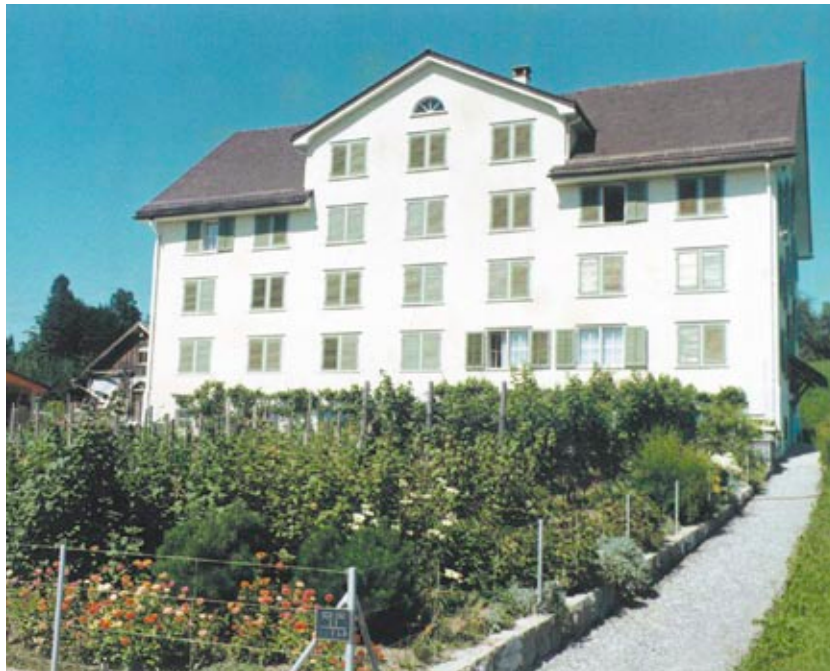
1915 ans EW-Stromnetz angeschlossen: Das ehemalige Bürgerheim in der Schönau.
