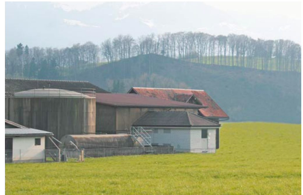
Unten: Die Trafostation Neufeld an der Benknerstrasse, neu erstellt 1991.
