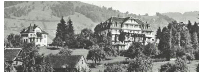
Verfügte bis 1918 über eine eigene Trafo-Station: ehemaliges Landerziehungsheim auf Hof Oberkirch.
